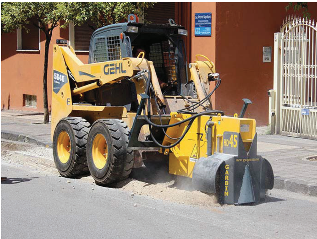
Fig.9 – Macchina operatrice con dotazione di fresa a disco per esecuzione di mini-trincee
